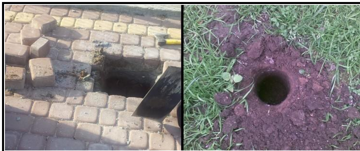
Przykład otworu w podłożu z kostki brukowej oraz otworu w glebie.
