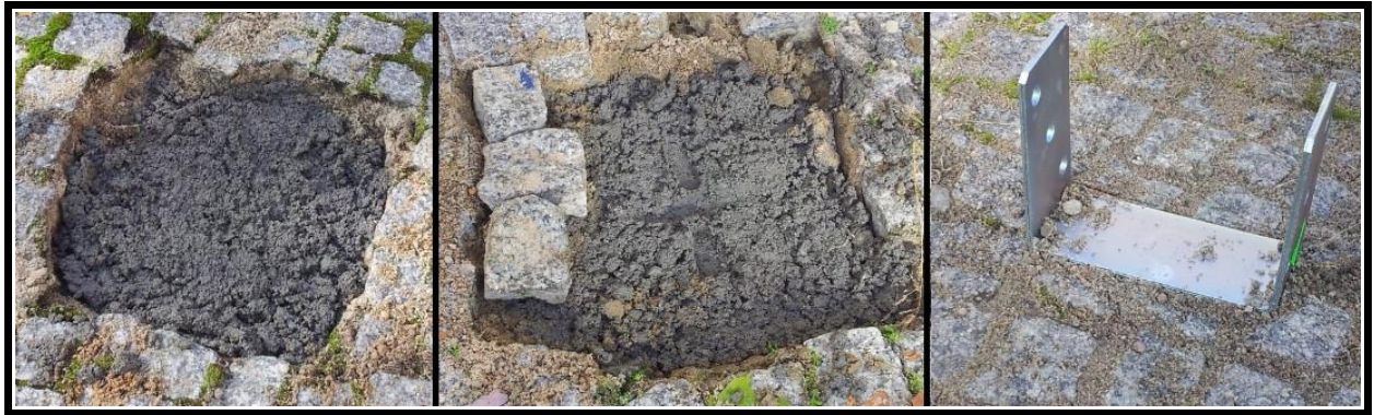
Zalanie otworu betonem.
